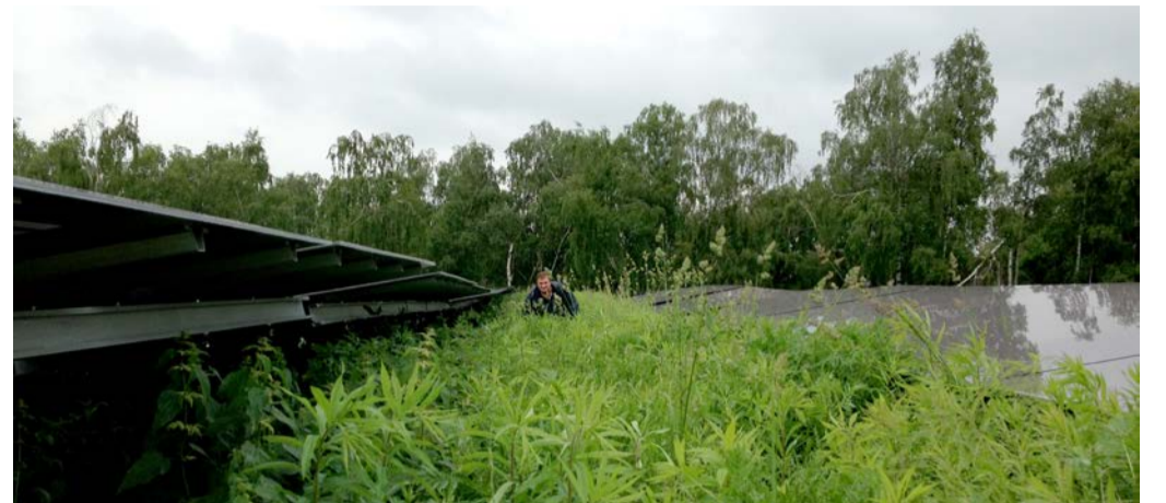
Foto: Solverde Bürgerkraftwerke Energiegenossenschaft eG
